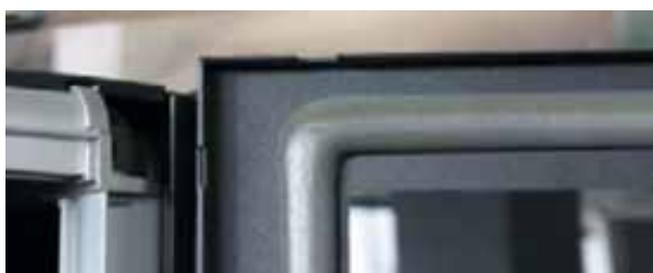
Joint polyuréthane assurant l'étanchéité sur tous les ouvrants (porte avant / arrière et panneaux latéraux)
